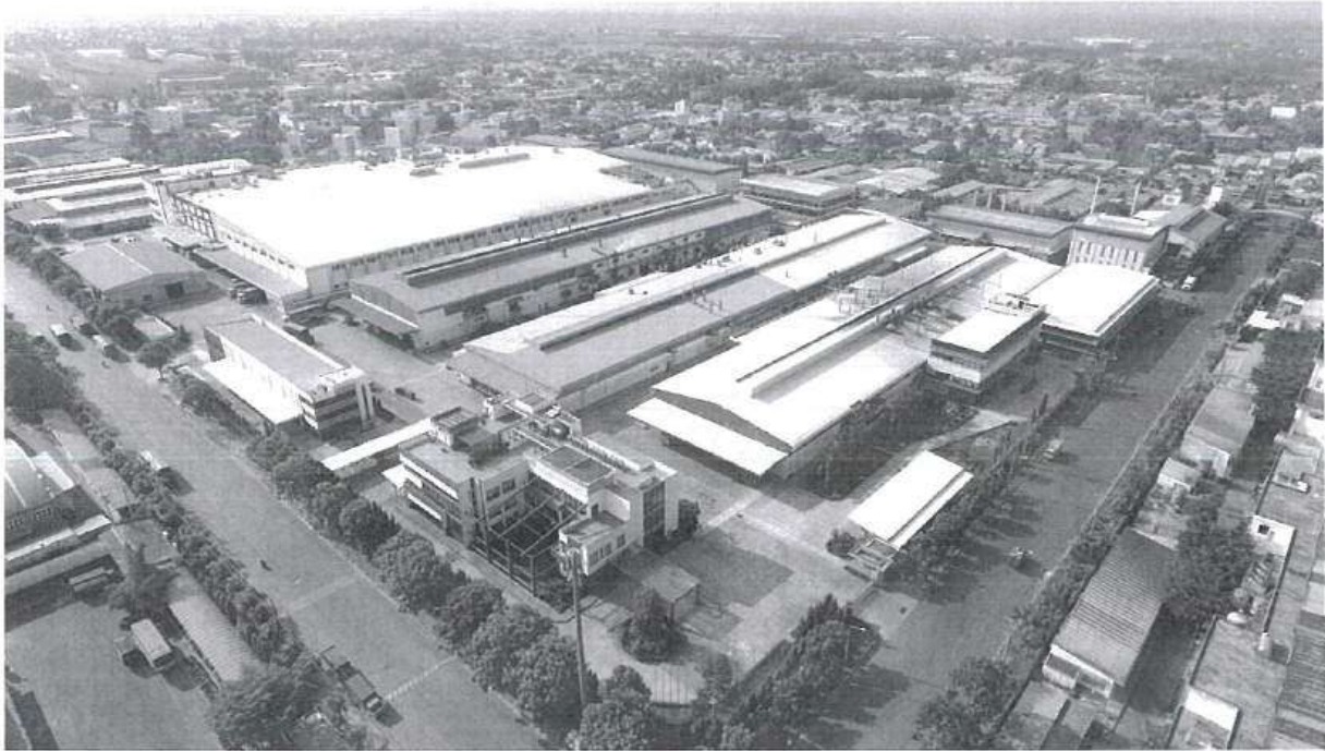
Hình 4: Nhà máy sản xuất theo tiêu chuẩn và đẳng cấp thế giới
